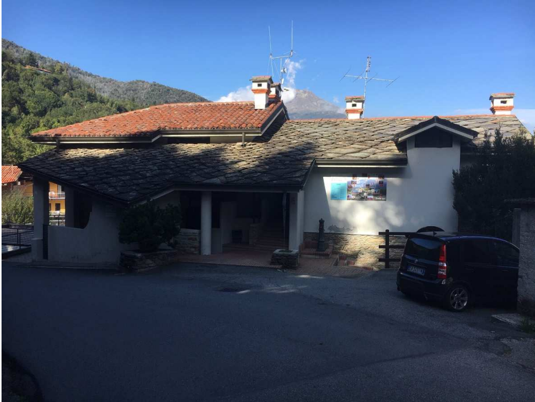
Fig. 1. Vista delle falde dove verrà installato il campo solare
