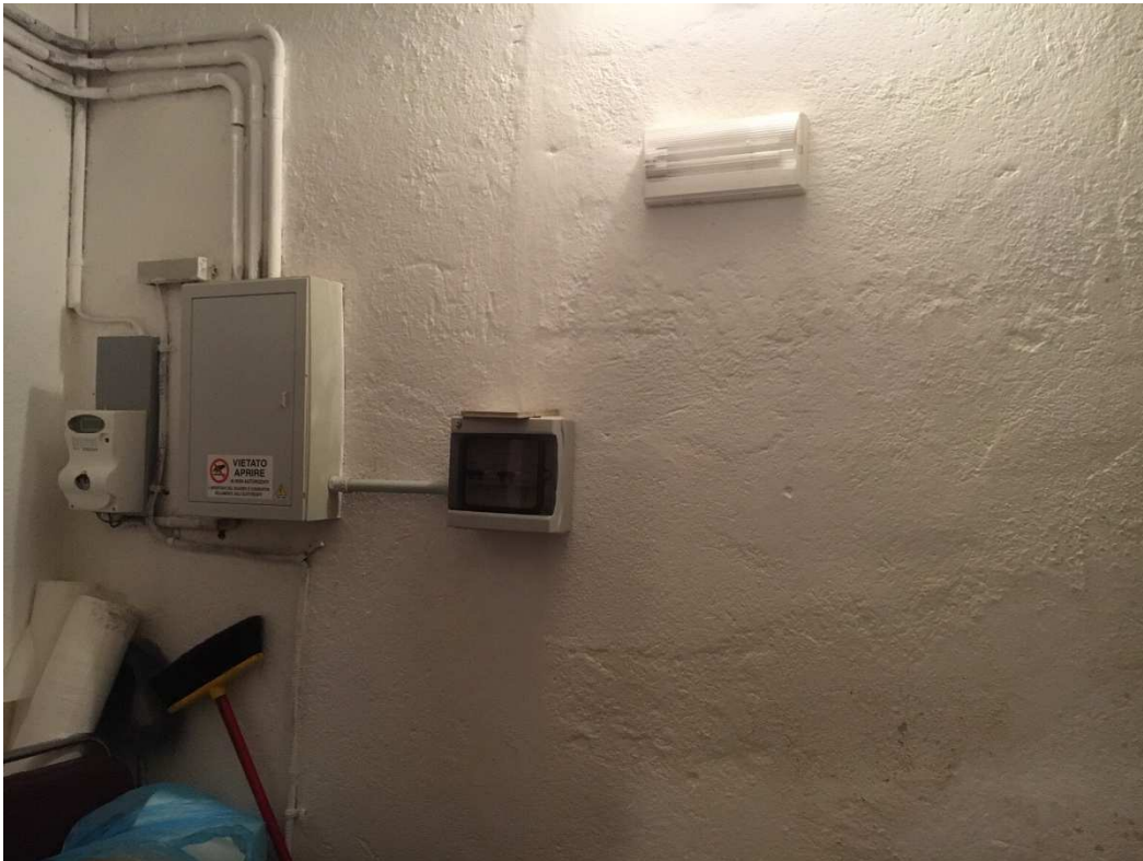
Fig. 2. Vista del vano tecnico
